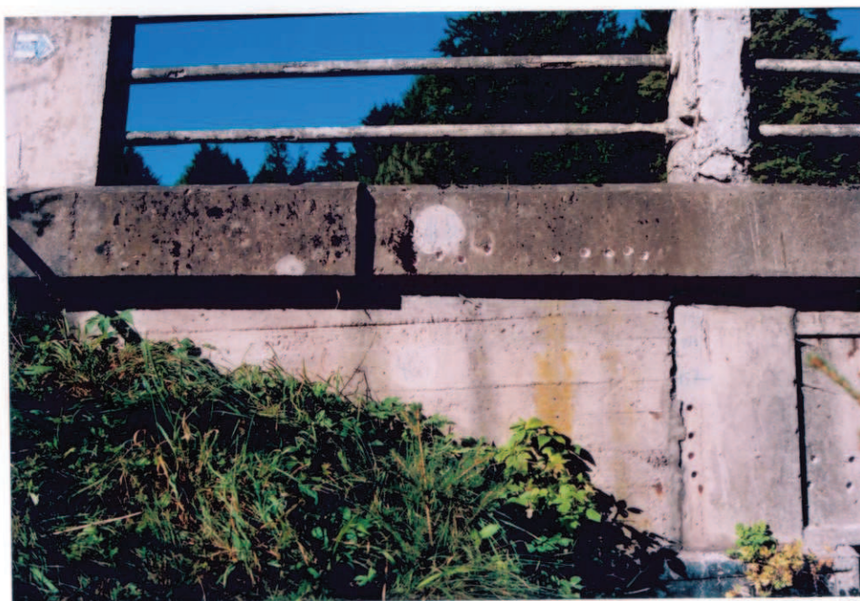
Obr.A17-21 Pravé křídlo I. podpěry. Pohled doleva, - v dilatační spáře není NK umožněn pohyb, křídlo poškozeno trhlinami, - první římsovka je posunuta doprava, po vodě, - druhý sloupek pravostranného zábradlí (na obr. vpravo) se rozpadá, - na čelo opěry a křídlo zatéká relativně málo.
