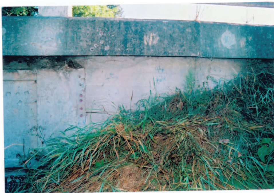
Obr.A17-20 Levé křídlo I. podpěry. Pohled doprava, - v dilatační spáře není NK umožněn pohyb, křídlo poškozeno trhlinami, - na čelo opěry a křídlo relativně málo zatéká.
