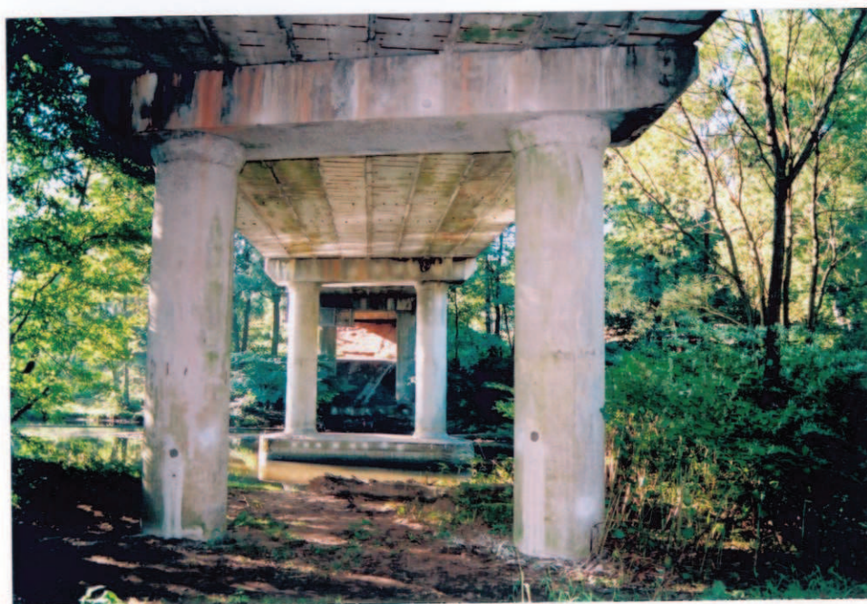
Obr.A17-16 Červenohorská strana IV. podpěry. Pohled proti směru staničení ke Slatině, - v pozadí III., II. i I. podpěra, - na úložný práh zatéká z úložné spáry, více na jeho povodní konec (vlevo). Inkrustace jsou zde zbarvené i korozivně, - tmavé kruhy na sloupech jsou dosud nezapravené otvory po jádrových vývrtech.
