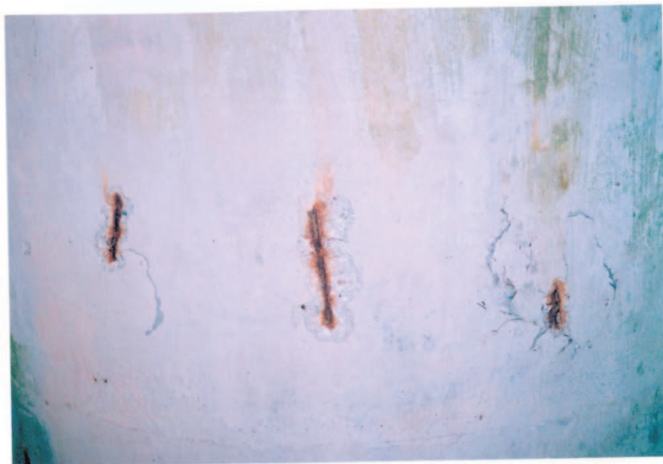
Obr.A18-28 Pravý sloup IV. podpěry. Pohled proti směru staničení, ke Slatině, - ojediněle obnažená výztuž trub "VIANINI", do kterých jsou betonovány sloupy podpěr.
