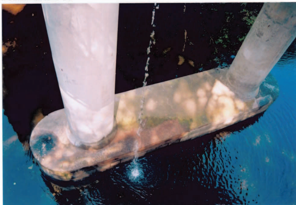
Obr.A16-05 Základový pás III. podpěry přibližně uprostřed řeky. Pohled zleva k Červené hoře, po vodě a dolů,
