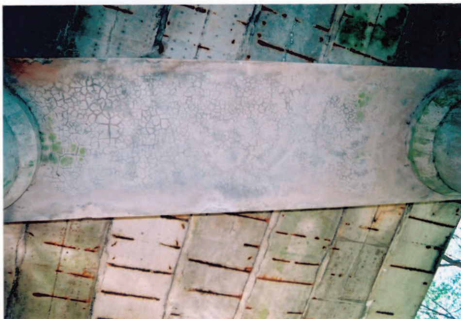
Obr.A18-29 Podhled úložného prahu IV. podpěry. Pohled z místa mezi sloupy přímo vzhůru, - omítka podhledu je poškozena trhlinami. Zatím ale neopadává.
