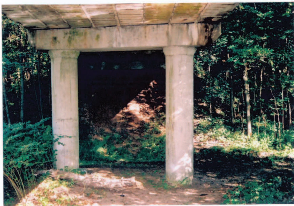
Obr.A17-22 Slatinská strana IV. podpěry. Pohled z prohlížečky ve směru staničení v Červené Hoře, - v pozadí V. podpěra, červenohorská opěra, - na úložný práh zatéká z úložné spáry, více na jeho konce a pod podélnými spárami mezi nosníky, - na pohledu všech nosníků rozsáhlá koroze příčné výztuže.
